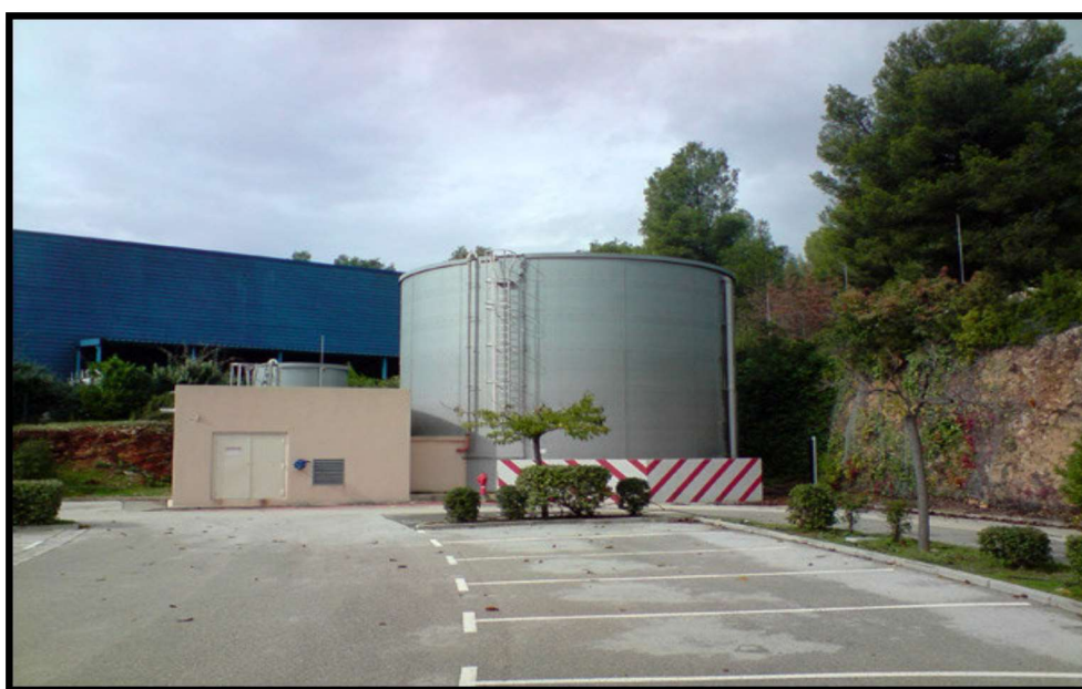
Cuve autonome réseau anti-incendie
